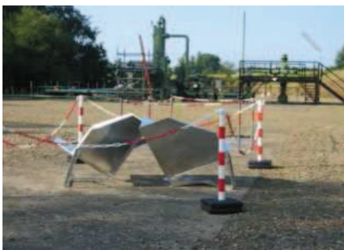
Fig. 12 : Réflecteurs installés dans la zone de stockage de gaz à proximité des puits pour garantir des points de mesure dans le futur
